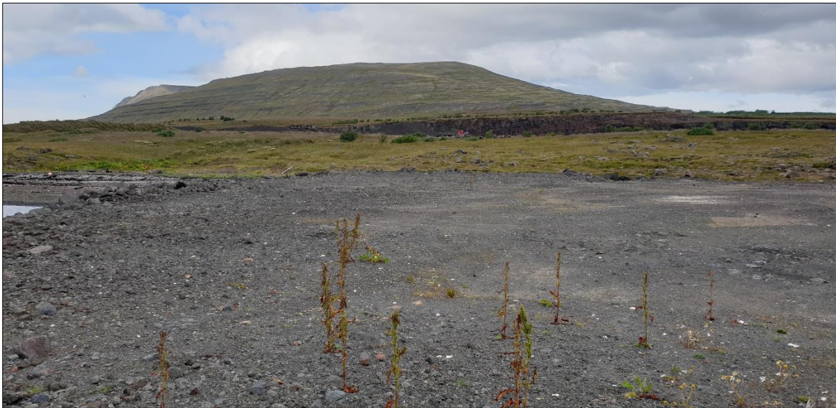
Mynd 2.4 Ljósmynd af fyllingunni á svæði 1, tekin í átt að Akrafjalli. Fyrir miðri mynd má sjá hvar unnt er að afla grjóts í grjótgarða eins og fjallað er um í kafla 4.3.
