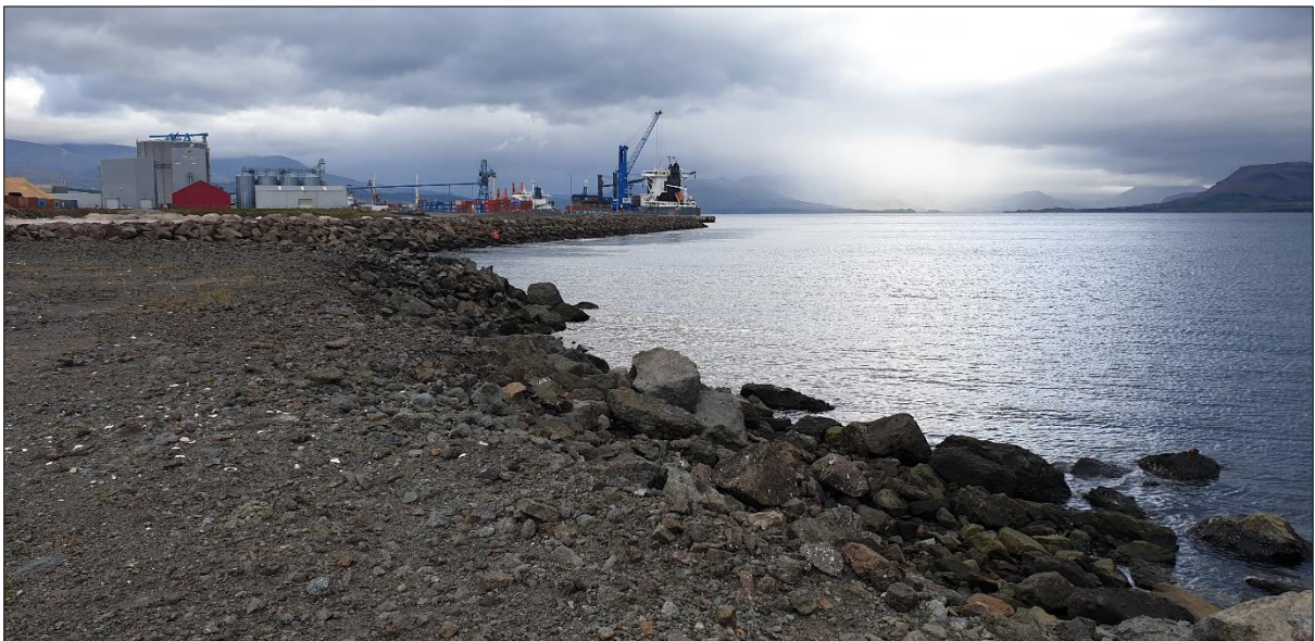
Mynd 2.3 Ljósmynd af svæðinu sem færi undir fyrirhugaða flæðigryfju á svæði 1, tekin til austurs. Myndin er tekin á fyllingunni sem nú þegar er til staðar.
